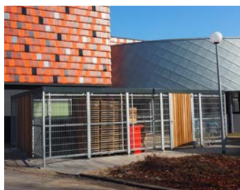
Zijwanden van traliepanelen, deuren van hout
