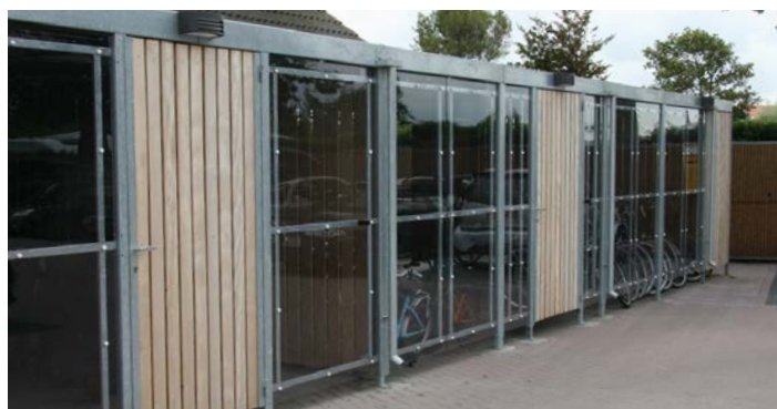
Zijwanden, achterwand en deuren bekleed met verticale, FSC® gecertificeerde hardhouten belatting, voorwand met glashelder polycarbonaat
