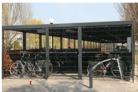
Wanden bekleed met traliepanelen, geheel gepoedercoat
