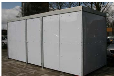
Wanden bekleed met opaal polycarbonaat
