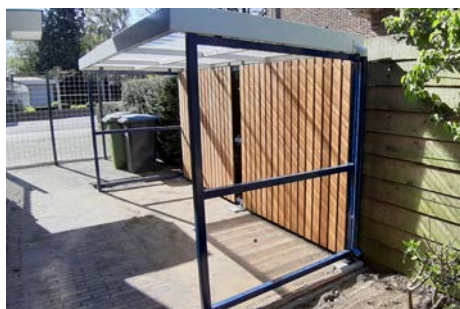
Geen zijwanden, dak van polycarbonaat, staalconstructie gepoedercoat
