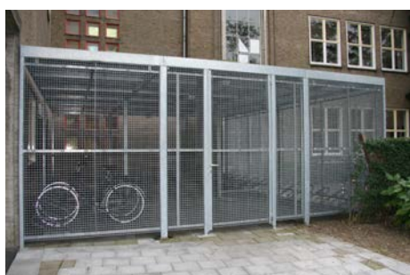
Wanden bekleed met persrooster
