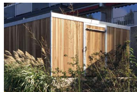
Wanden bekleed met verticale open belatting, deur met elektrische dagschootontgrendelaar
