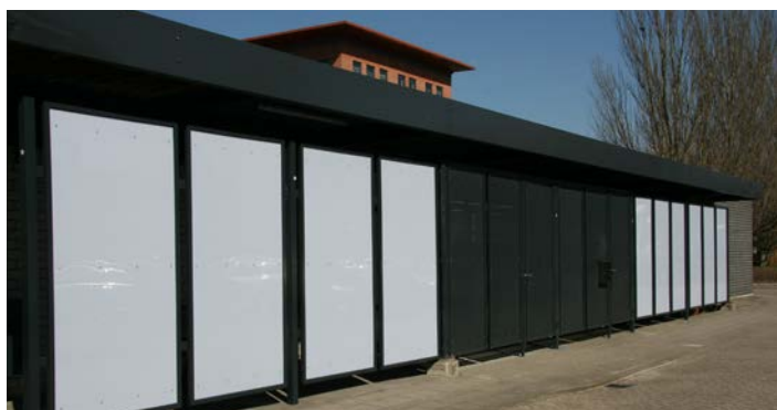
Wanden bekleed met opaal polycarbonaat, deuren met perfolaat gepoedercoat in RAL 7016, antracietgrijs
