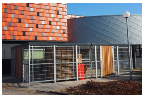
Met zijwanden van traliepanelen, deuren van hout, boei gepoedercoat
