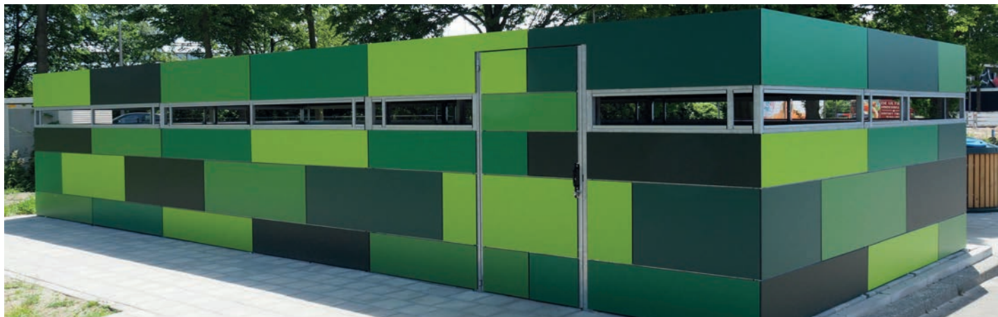
Wanden bekleed met Trespa beplating
