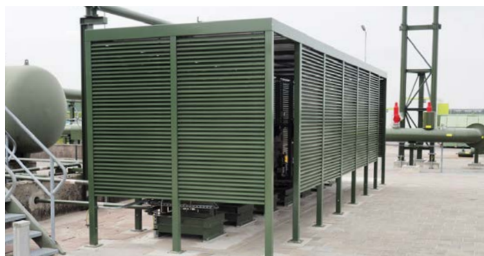
Wanden bekleed met Storax lamellen type ST-050 HF, gepoedercoat in RAL 6003, olijfgroen
