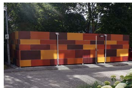
Wanden bekleed met Trespa beplating aangebracht in wildverband
