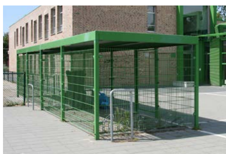
Staalconstructie en traliewanden gepoedercoat
